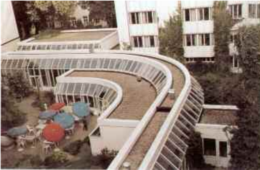
Neubaubereich mit Cafeteria
